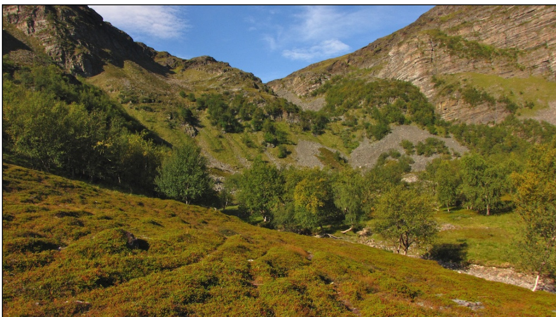
Figur 5. Nedre del av vannveien. Tunnelpåhugg vi bli i overkant av steinura i bakgrunnen og vannet føres ned til kraftverket på flata i nedgravd rør. Foto Geir Arnesen.
